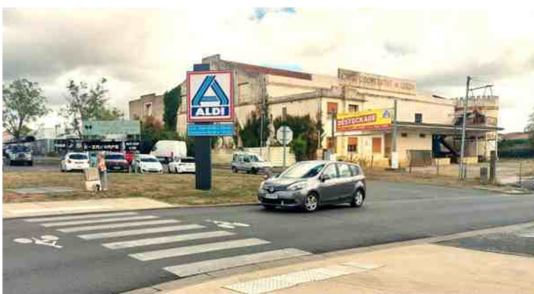
Le supermarché Aldi et l'ancienne cave coopérative vont faire l'objet de travaux importants. S. G.
